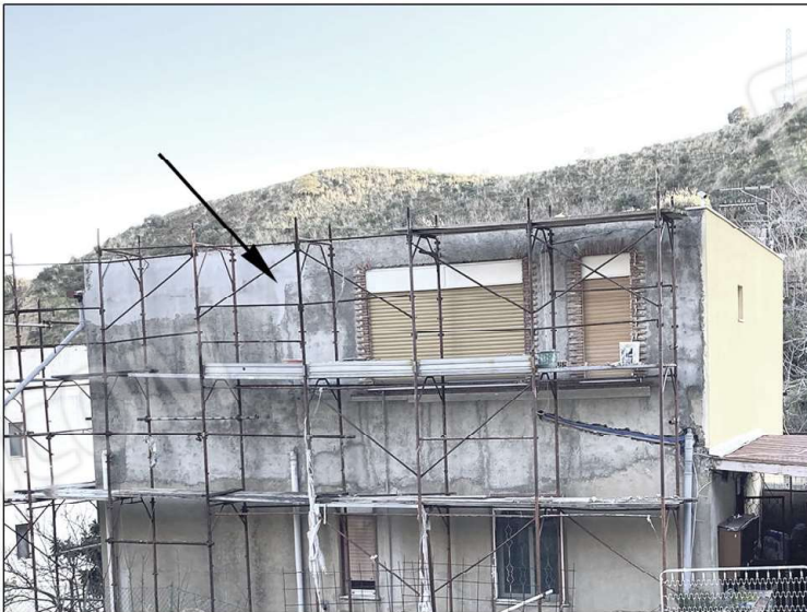
prospetto lato nord
