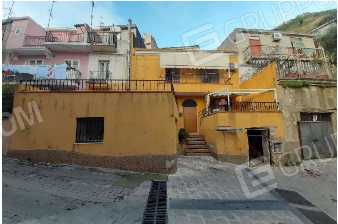
FOTO 2 – PROSPETTO SU VIA FULCI
