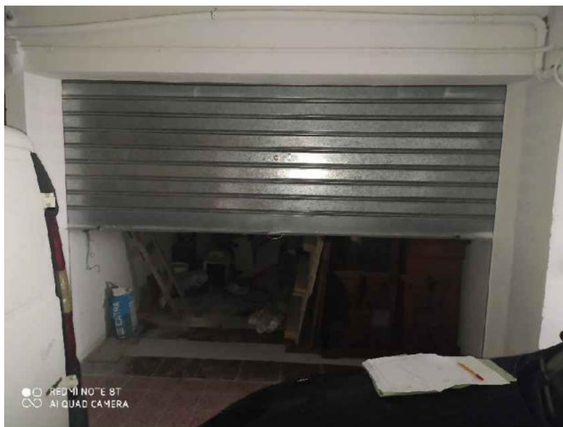
Foto n° 22 – Sub. 25, Ingresso al Garage
