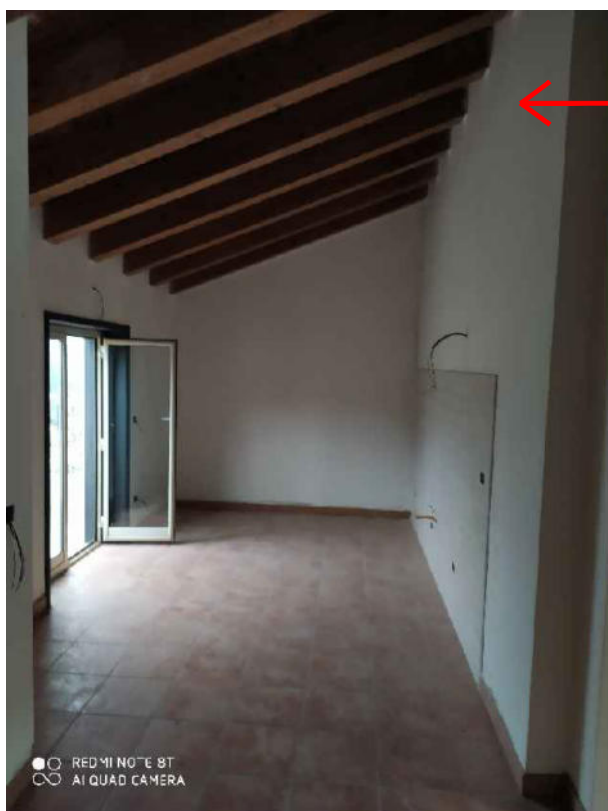
Foto n° 18 – Sub. 15, Locale sgombero
