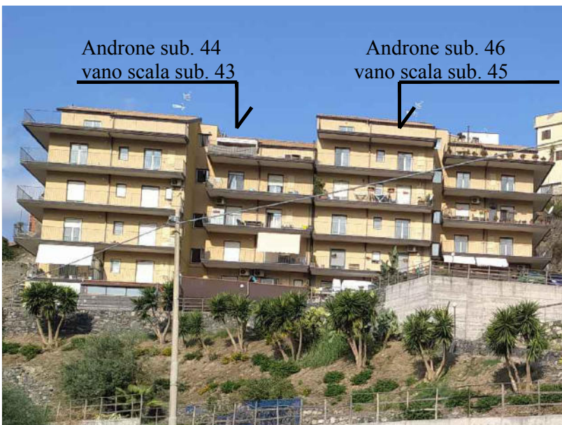
Foto n° 2 – Particella 844 (due corpi di fabbrica contigui con vani scala di pertinenza)
