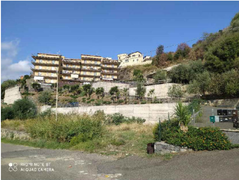
Foto n° 1 – Corpi di fabbrica (part. 844) e accesso dalla via Salita Cavallaro
