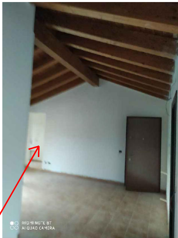
Foto n° 14 – Sub. 15, Ingr. – locale sgombero
