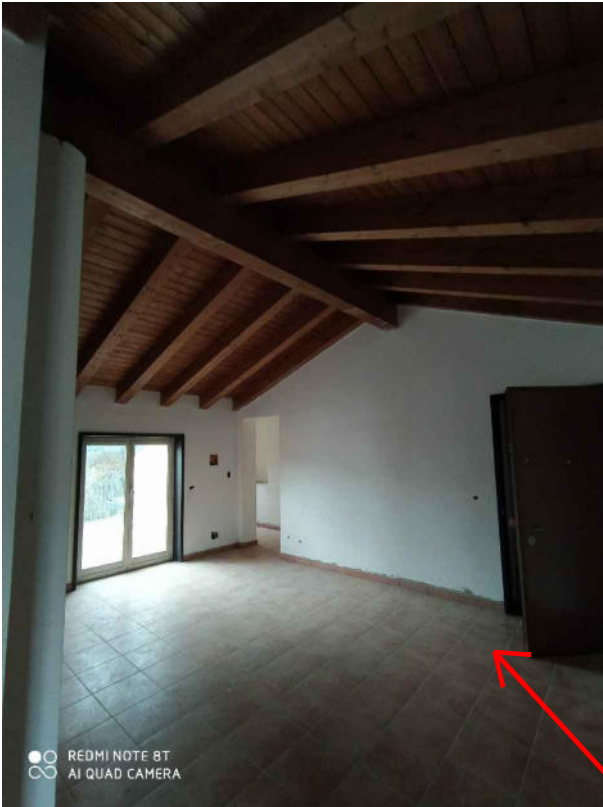
Foto n° 57 – Sub. 36, Ingresso – locale sgombero
