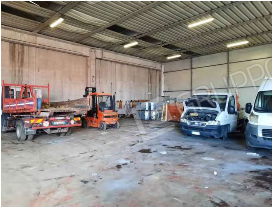
foto n°5 - capannone industriale | vista 2
