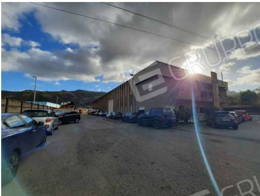
foto n°1 - capannone industriale e locali ufficio | vista esterna
