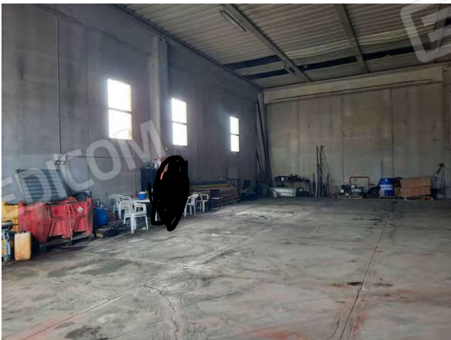
foto n°6 - capannone industriale | vista 3
