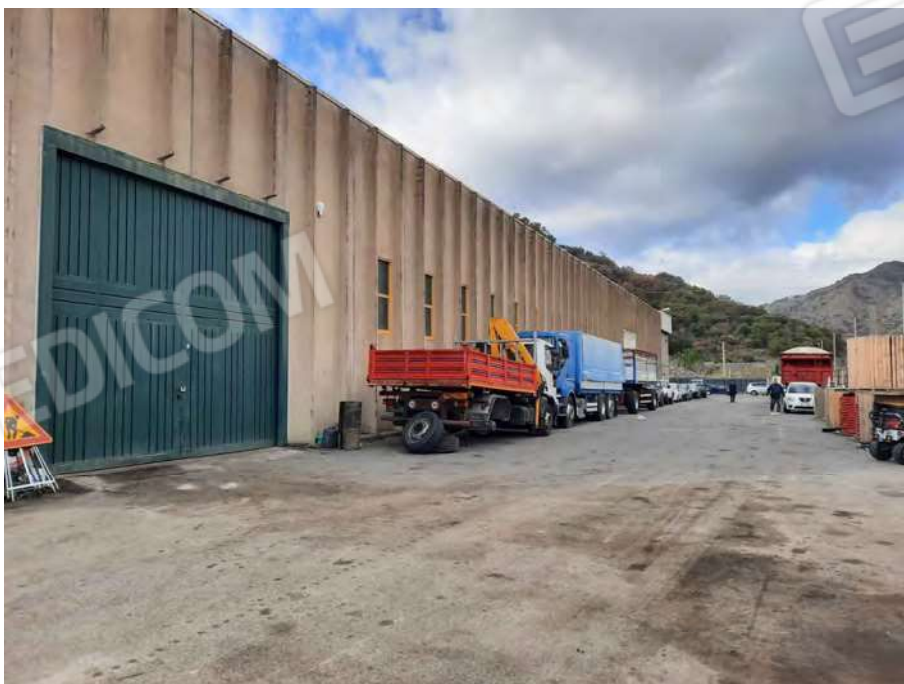
foto n°2 - capannone industriale e corte di pertinenza esclusiva | vista esterna
