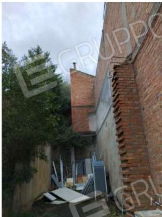
Foto n. 6 – Vista della particella 889
