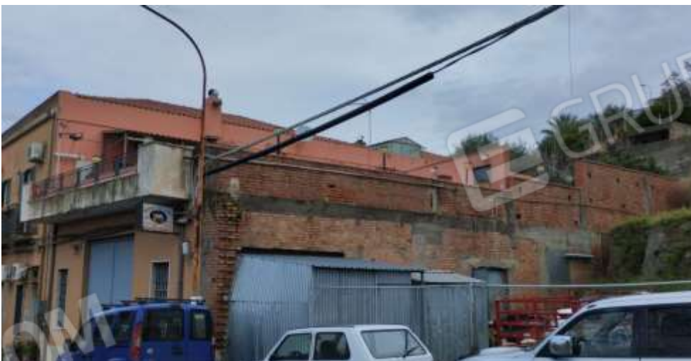
Foto n. 2 – Foto laterale dell'edificio dalla via pubblica
