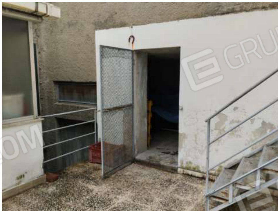
Foto n. 12 – accesso deposito piano primo part 242 sub. 10
