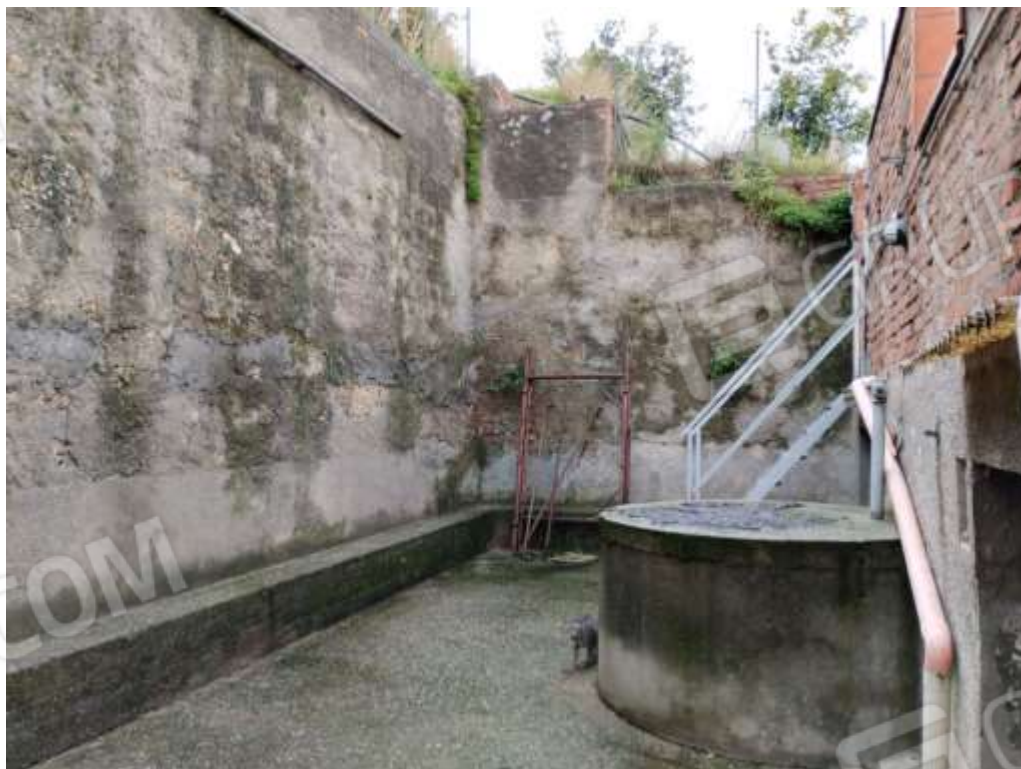
Foto n. 10 – Corte esterna aggraffata alla part. 242
