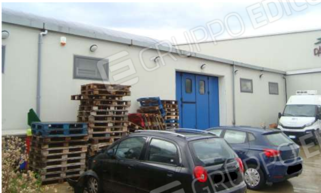
Foto n. 9 – fabbricato e corte esclusiva (sub. 9)
