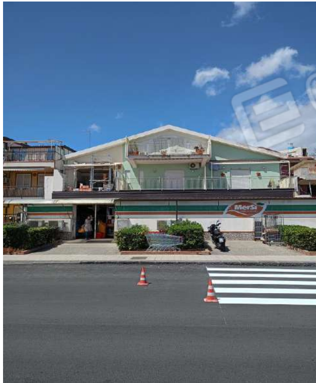
Foto 2: vista immobile da via Cristoforo Colombo
