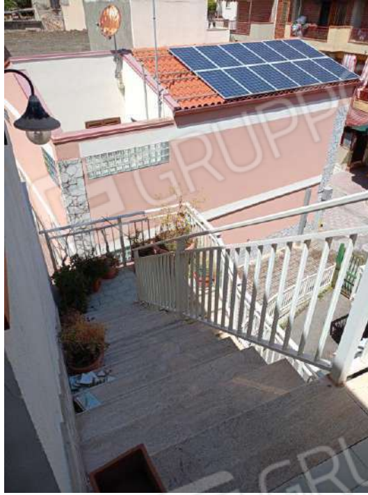
Foto 5: vista su corpo scala
