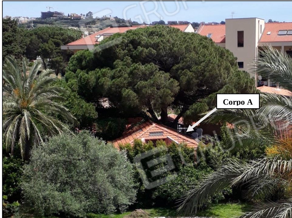
FOTO 03: vista copertura Corpo A.
