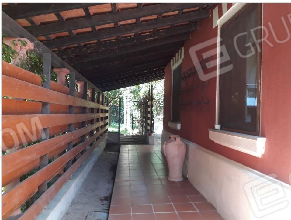
FOTO 08: vista laterale facciata nord.
