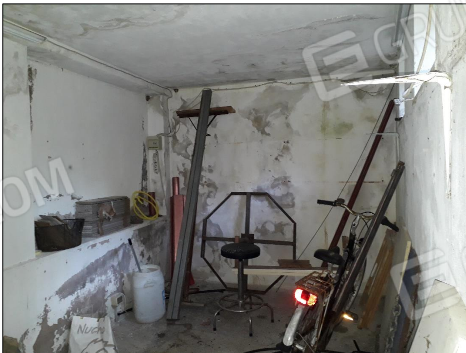
FOTO 18: interno locale deposito.
