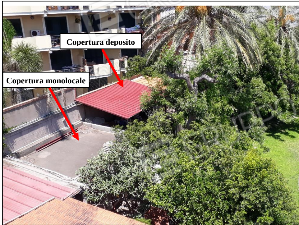
FOTO 19: veduta delle coperture.
