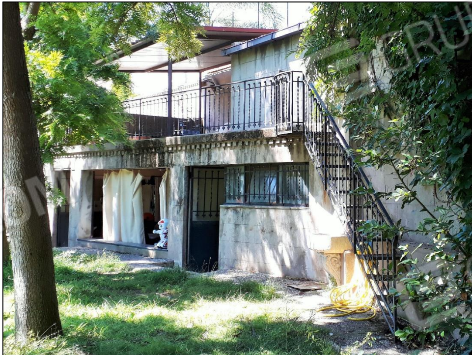
FOTO 23: veduta locali deposito e terrazza.
