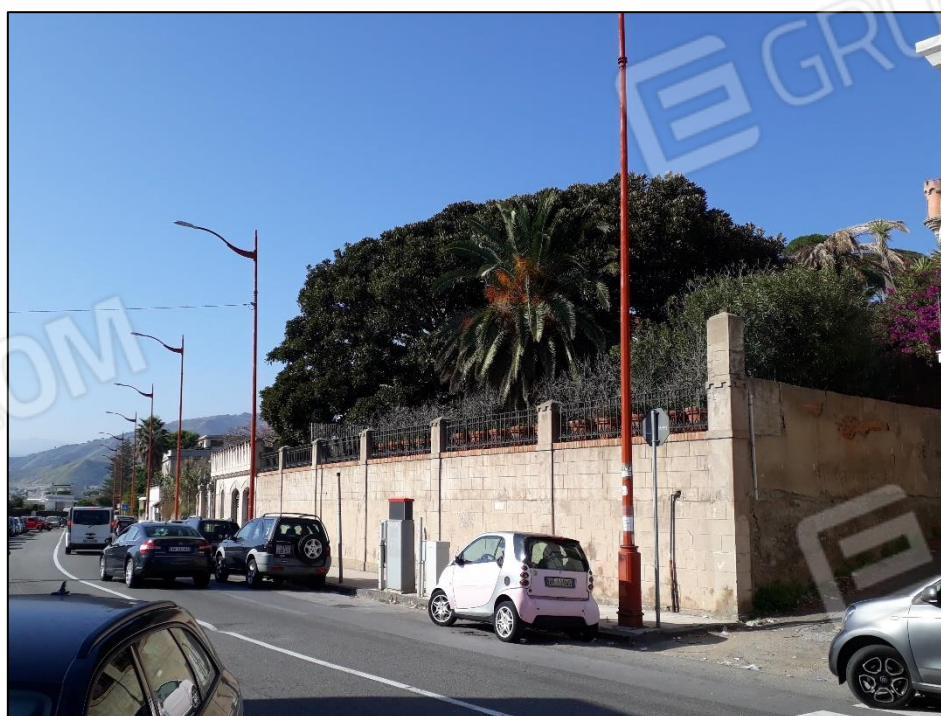
FOTO 22: veduta corte dalla via Consolare Pompea
