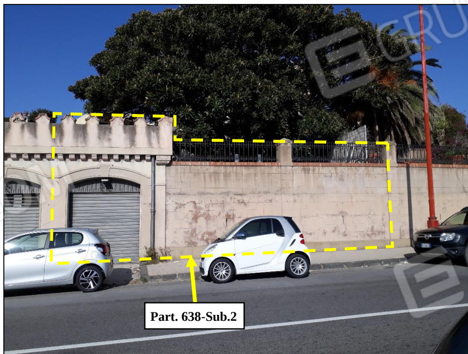
FOTO 14: prospetto su via Consolare Pompea
