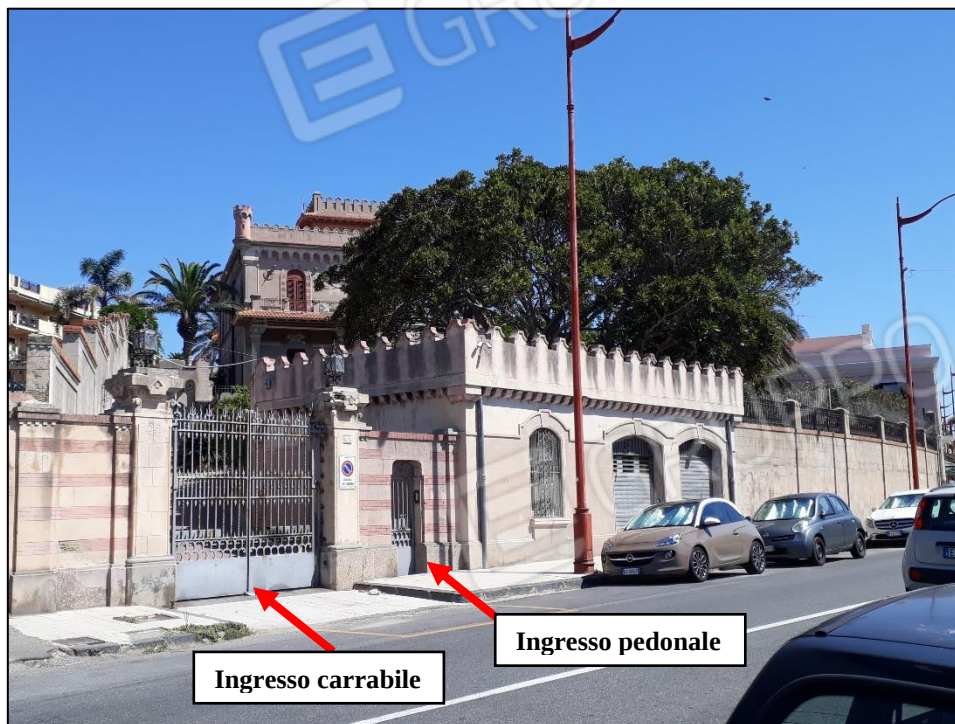
FOTO 21: accesso carrabile e pedonale sulla via Consolare Pompea.
