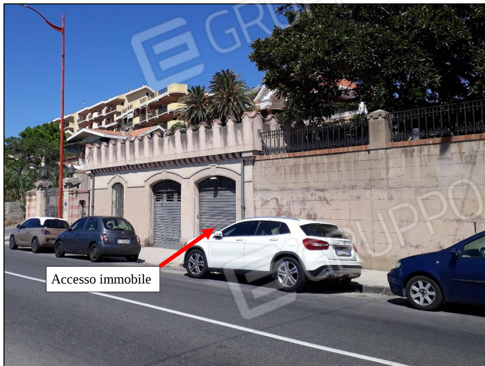
FOTO 13: veduta fabbricato dalla via Consolare Pompea.
