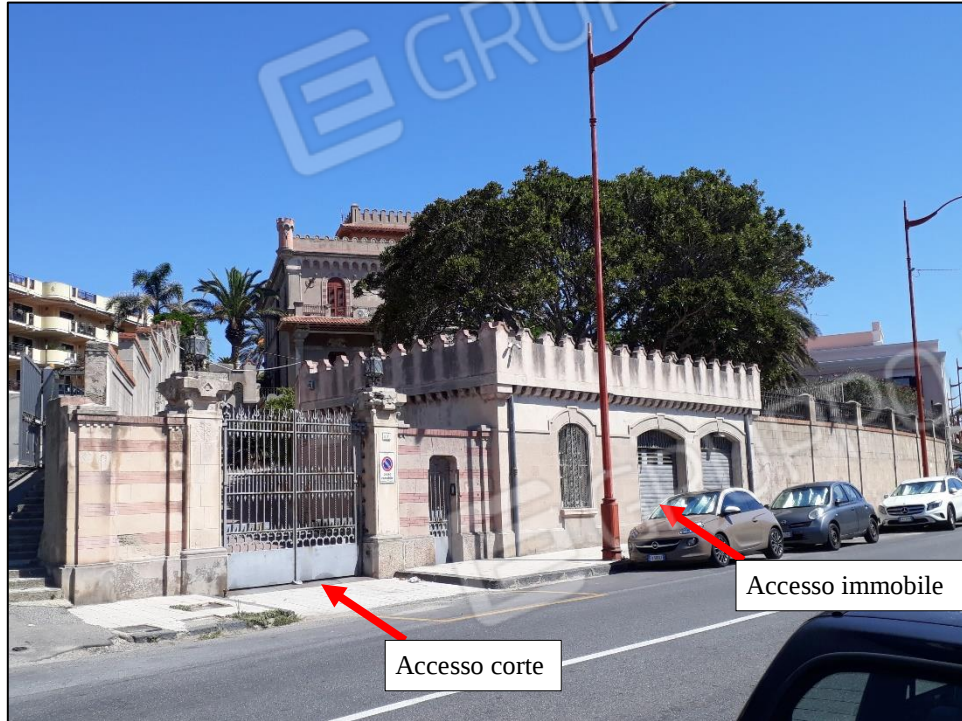
FOTO 03: veduta fabbricato dalla via Consolare Pompea.
