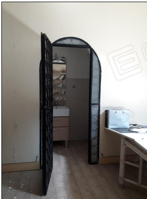
FOTO 18: locale sottoscala adibito a w.c.
