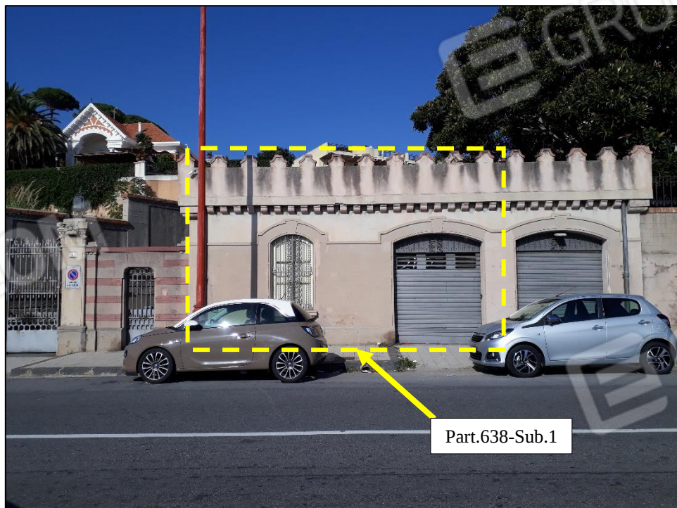
FOTO 04: prospetto sulla via Consolare Pompea.
