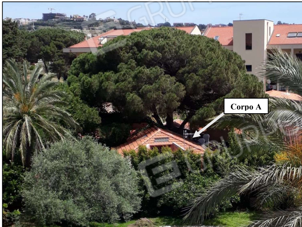
FOTO 03: vista copertura Corpo A.
