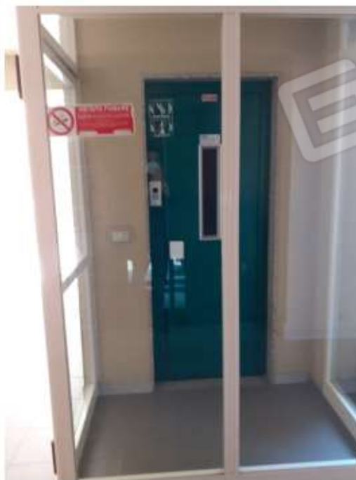
Foto nr. 2 : particolare del corpo ascensore
