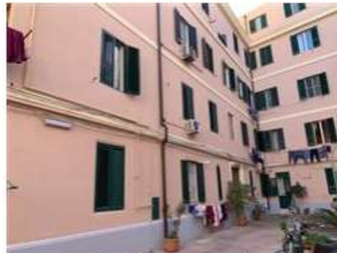
vista del prospetto su cortile
