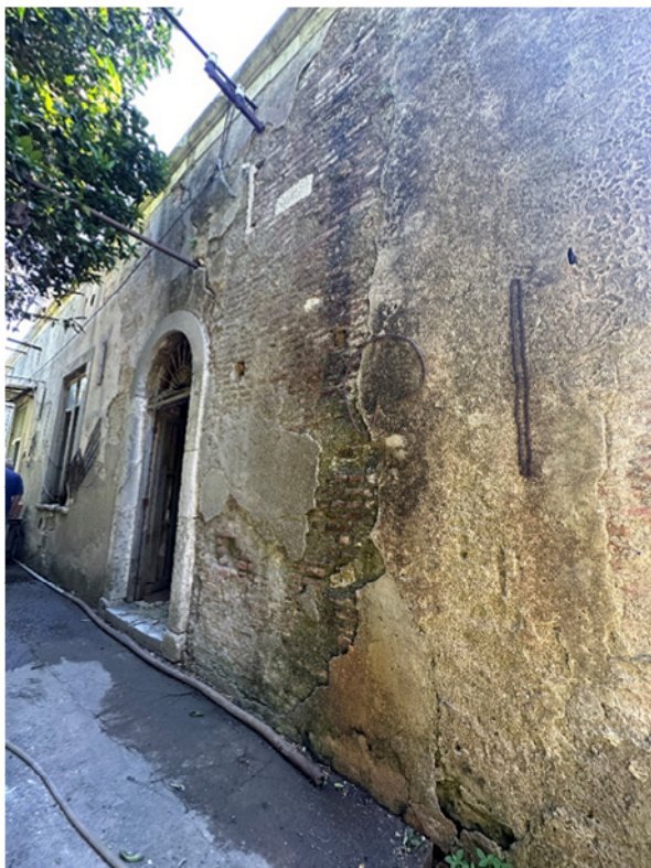
Foto nr. 19 : particolare della facciata , da ristrutturare – piano terra -
