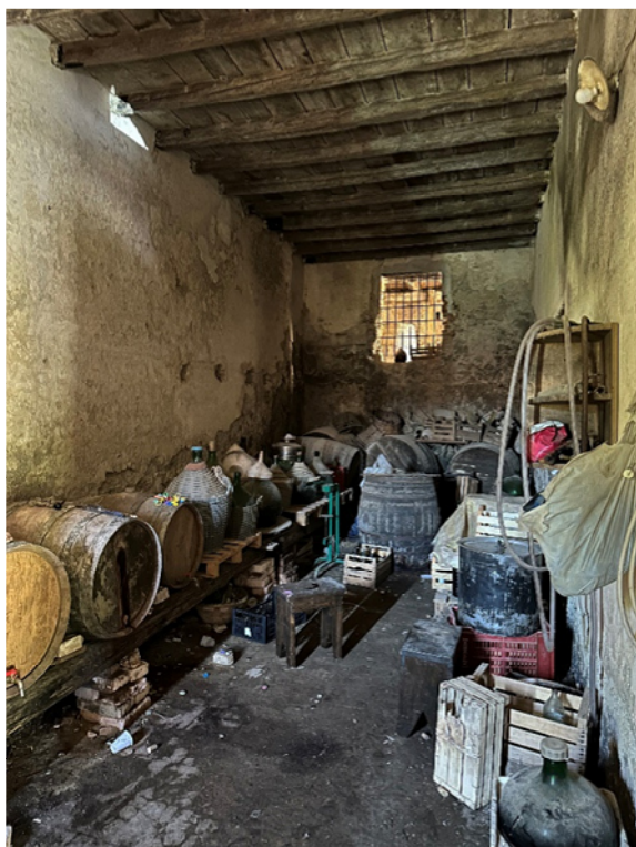
Foto nr. 13 : deposito, piano seminterrato – part. 127 – lotto nr. 1 -
