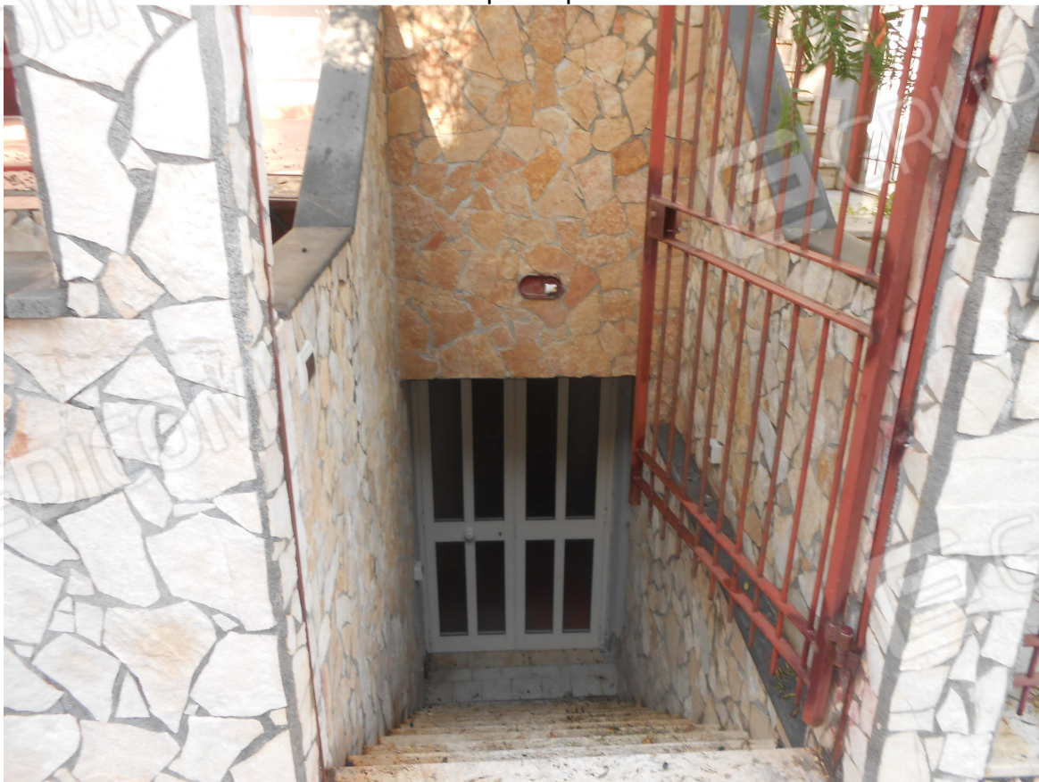
FOTO N. 4 – Scale che conducono al primo piano sottostrada
