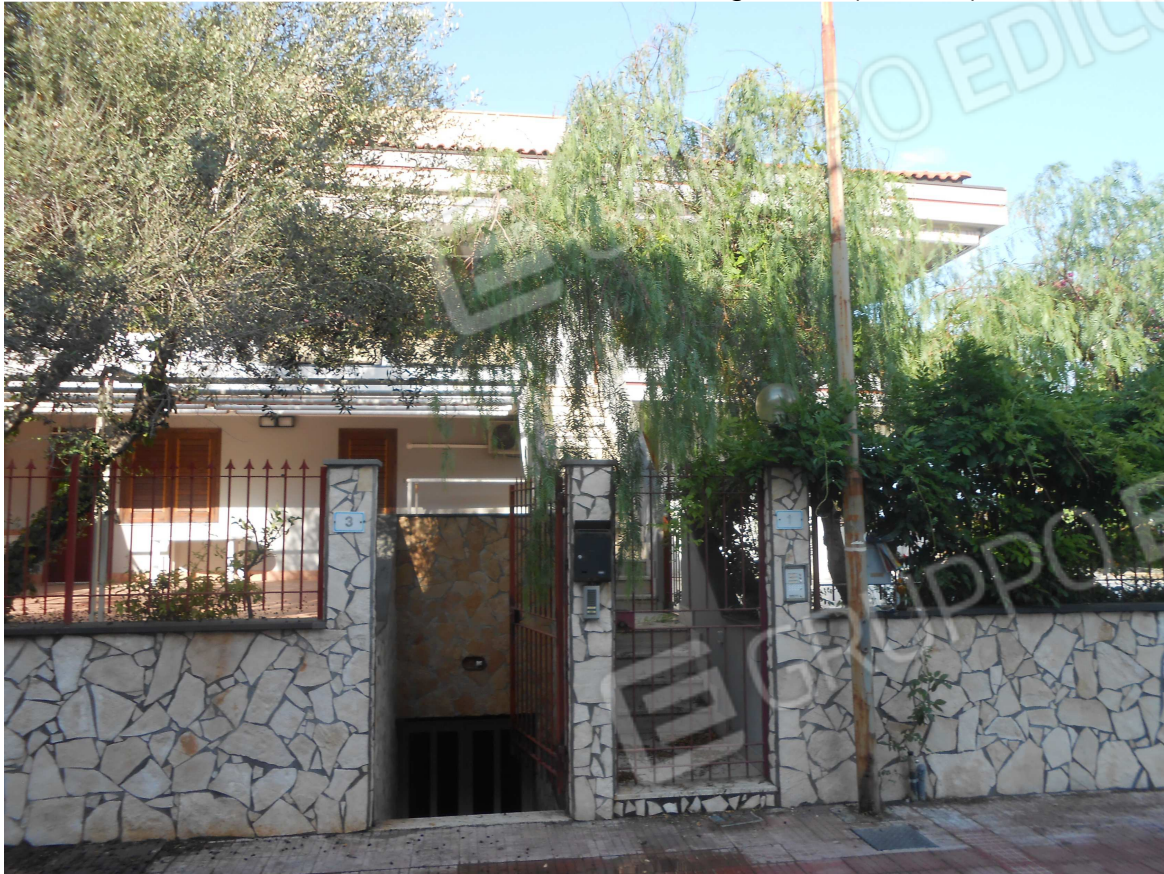
FOTO N. 3 – Cancelli di accesso al laboratorio artigianale (n. civ. 3)
