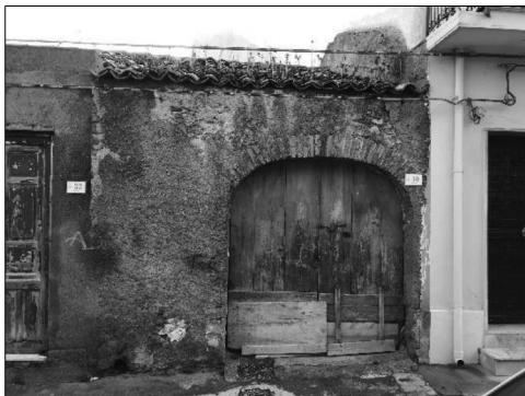
Prospetto su Via Marina
