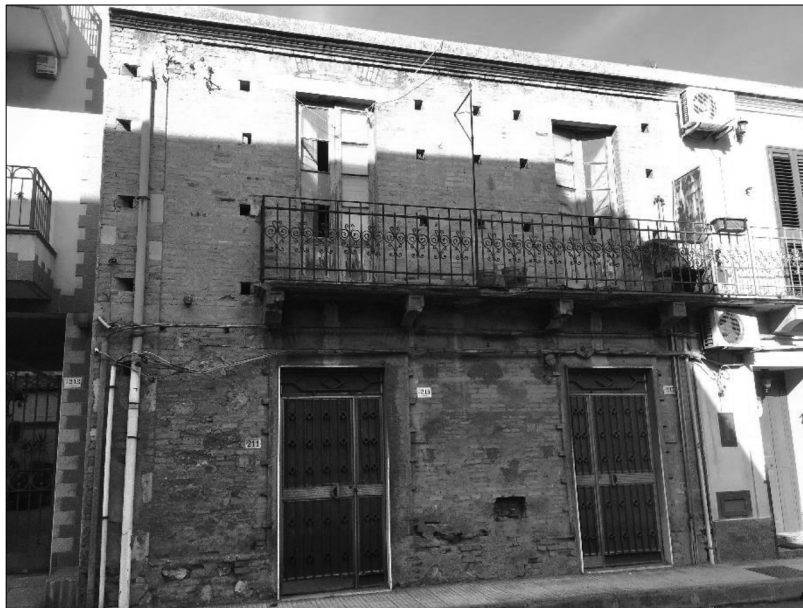
Prospetto su Via Nazionale con accesso da n. civici 215 e 217
