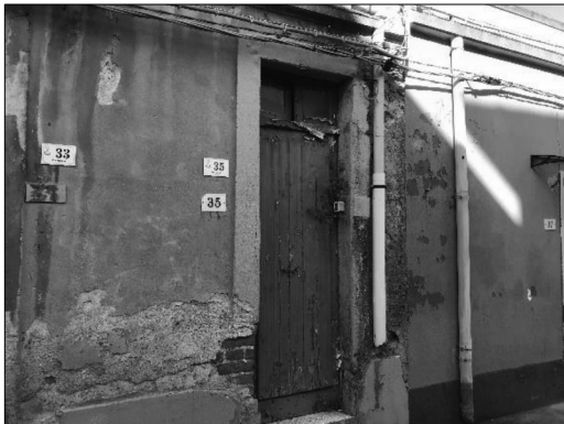
Prospetto su Via Marina
