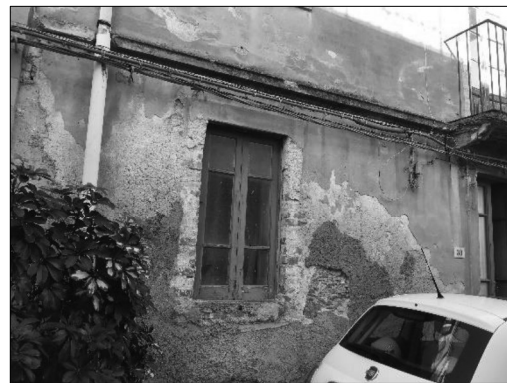
Prospetto su Via Marina
