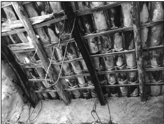
Parte del tetto ancora visibile
