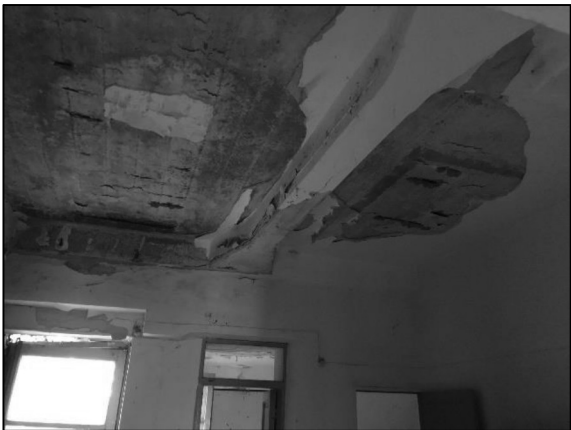
Condizioni del solaio
