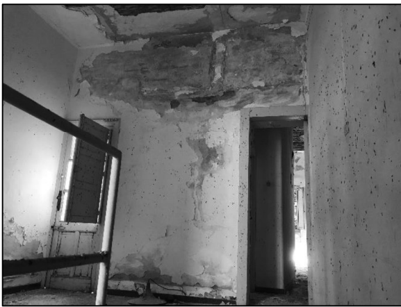
Stanze con evidenti distacchi intonaco
