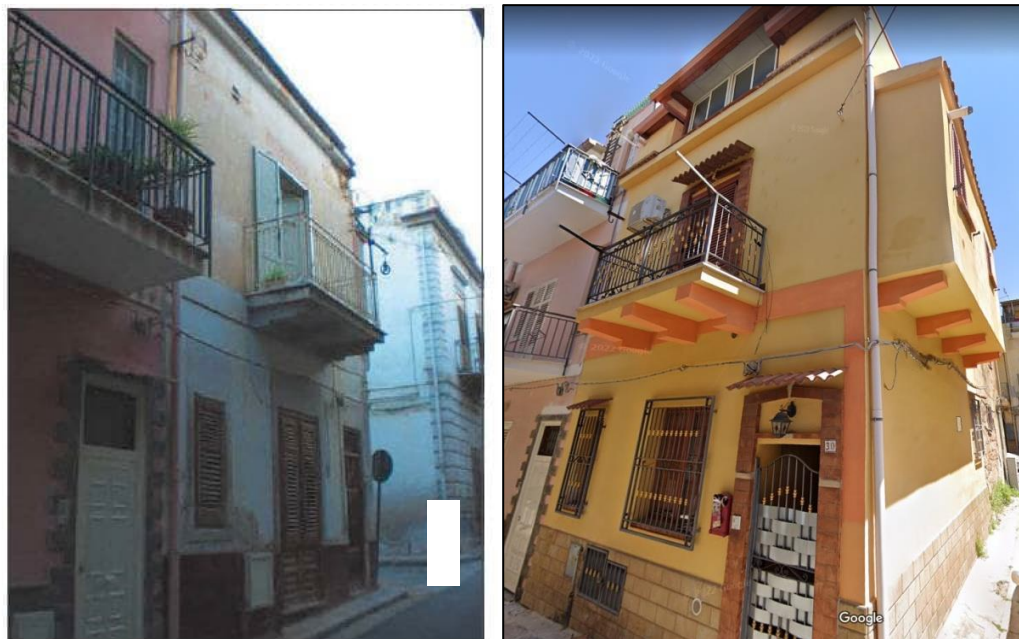
Raffronto tra l'immagine del fabbricato inserito nel P.P.E. del 2007 e lo stato attuale
