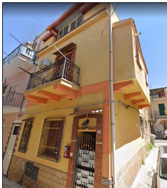
Foto 1– Prospetto del fabbricato
