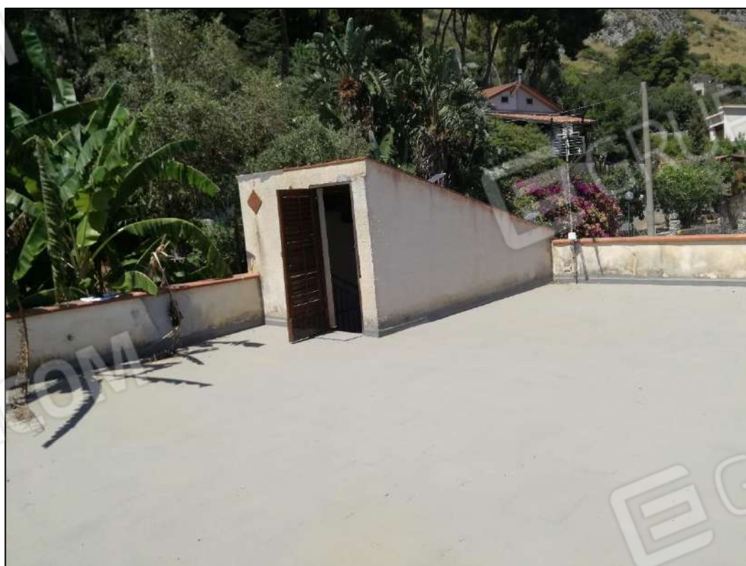
Foto 21 – scala accesso terrazzo
