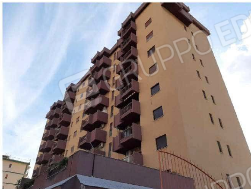
1. Vista edificio da via Savonarola
