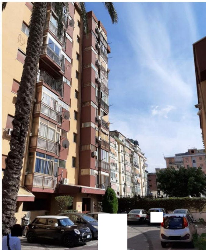
2. Vista edificio dal cortile interno
