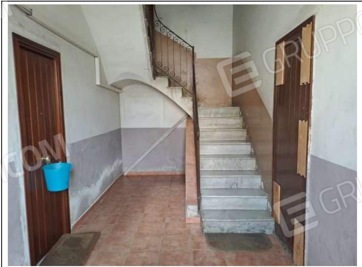
Foto n. 4 – Immobile sito in Palermo, Via Brancaccio n. 12, piano 2°. Vista del corpo scala
