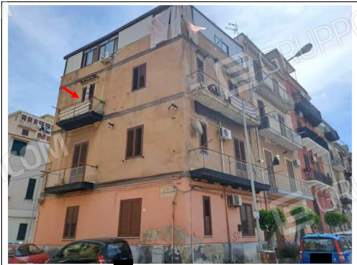
Foto n. 2 – Immobile sito in Palermo, Via Brancaccio n. 12, piano 2°. Prospetto su Via Letterio Lizio Bruno
