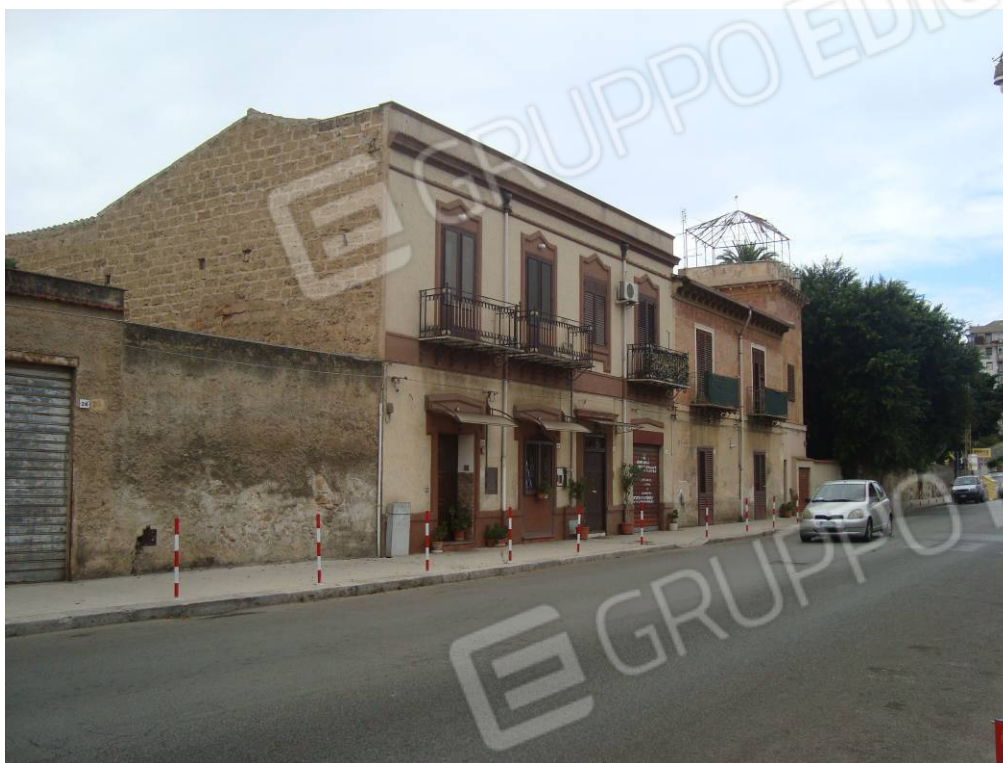
Vista complessiva della palazzina comprendente le unità immobiliari sub 6 e 7
