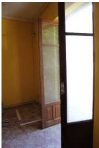
Particolare infisso esterno Vano (2)
