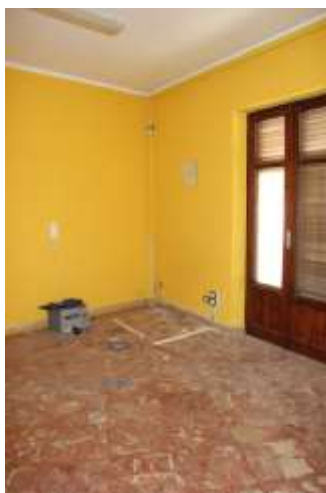
Vano (2) posto a nord-ovest
