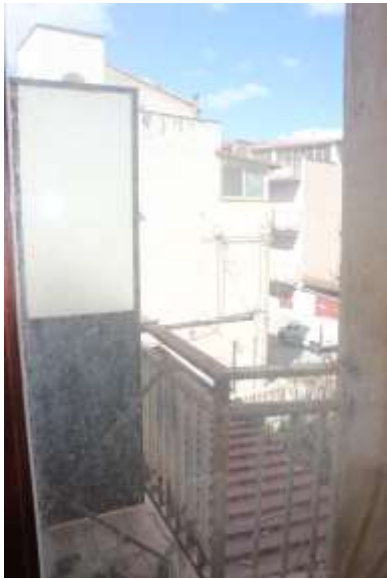
Porzione di Balconcino della cucina
