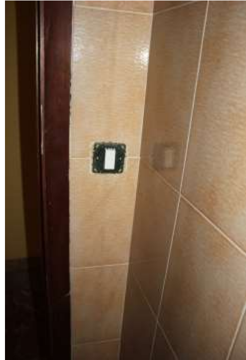
Particolare rivestimento bagno
