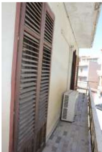
Balconcino su via C. Di Bella
