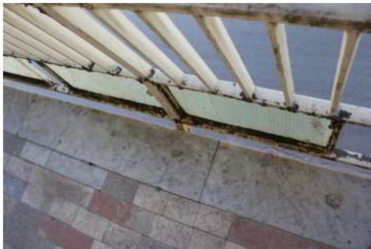
Particolare pavimentazione del balconcino su via C. Di Bella
