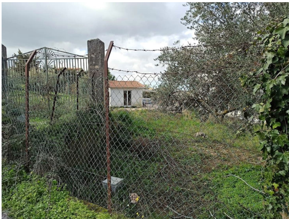
VISTA DEL PICCOLO FABBRICATO DALLA STRADA
