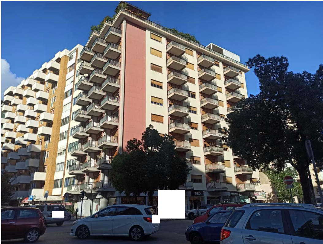
VISTA DELL'EDIFICIO CONDOMINIALE DA VIALE LAZIO
