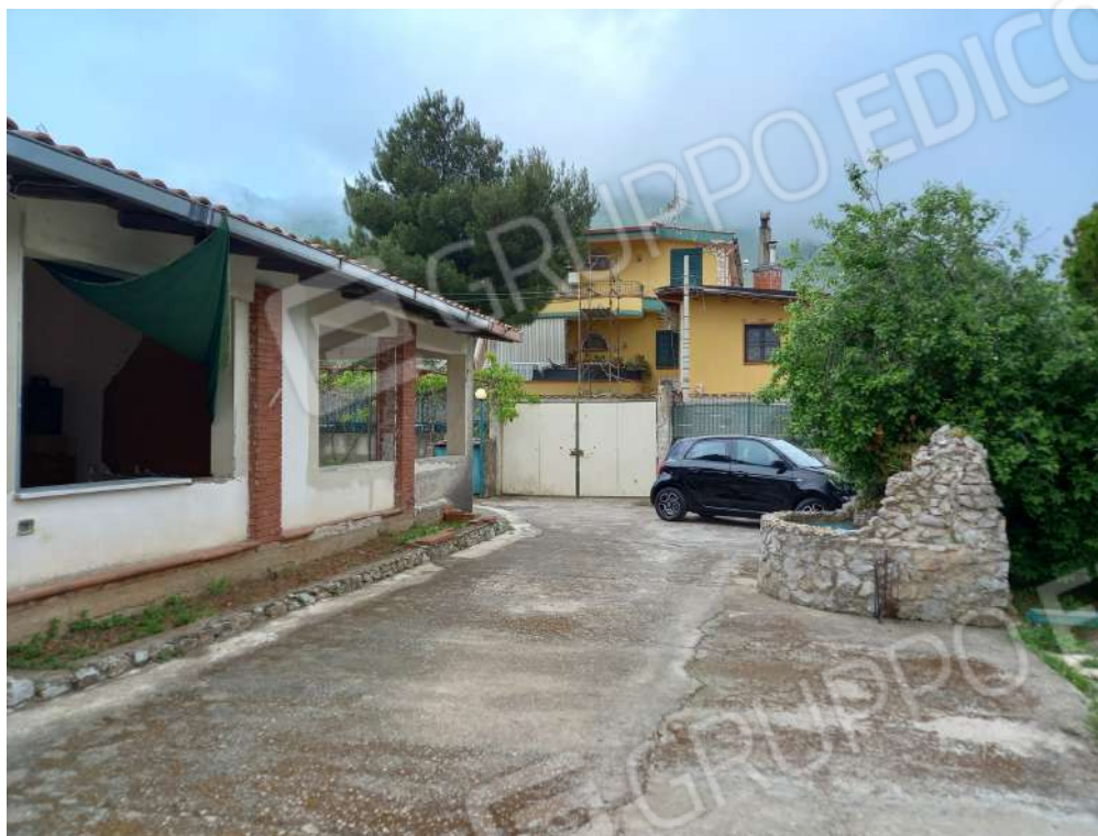
Fig. 4 Vista ingresso e corte.
