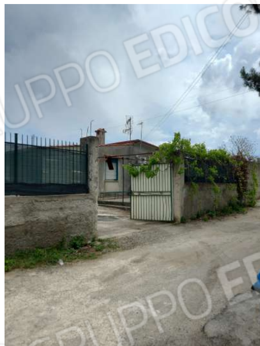
Fig. 2 Cancello d'ingresso all'unità.
