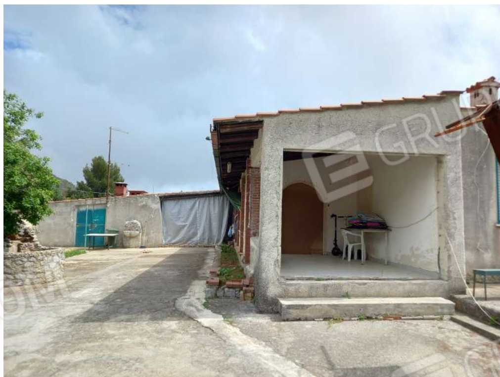
Fig. 3 Vista del fabbricato dal cancello di ingresso.
