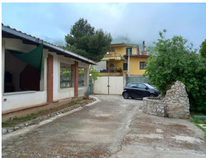
Fig. 19 Vista ingresso e corte.
