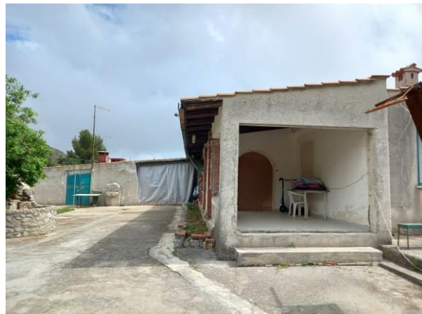
Fig. 7 Vista del fabbricato e dell'area antistante.
