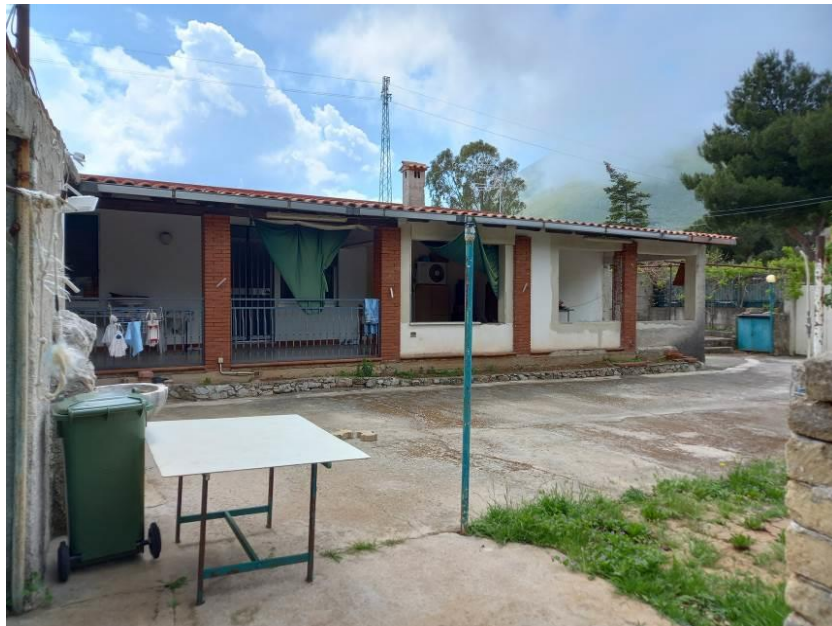
Abitazione piano terra con corte pertinenziale, Stradale Bellolampo (PA).
