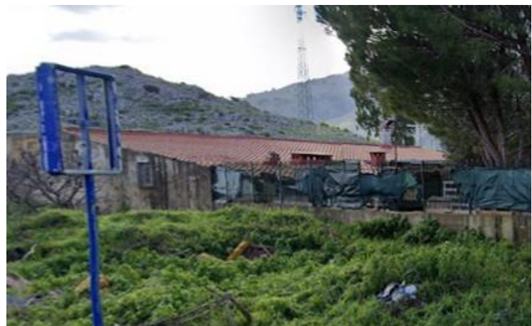
Figg. 39, 40 Immagini della copertura dell'immobile.
