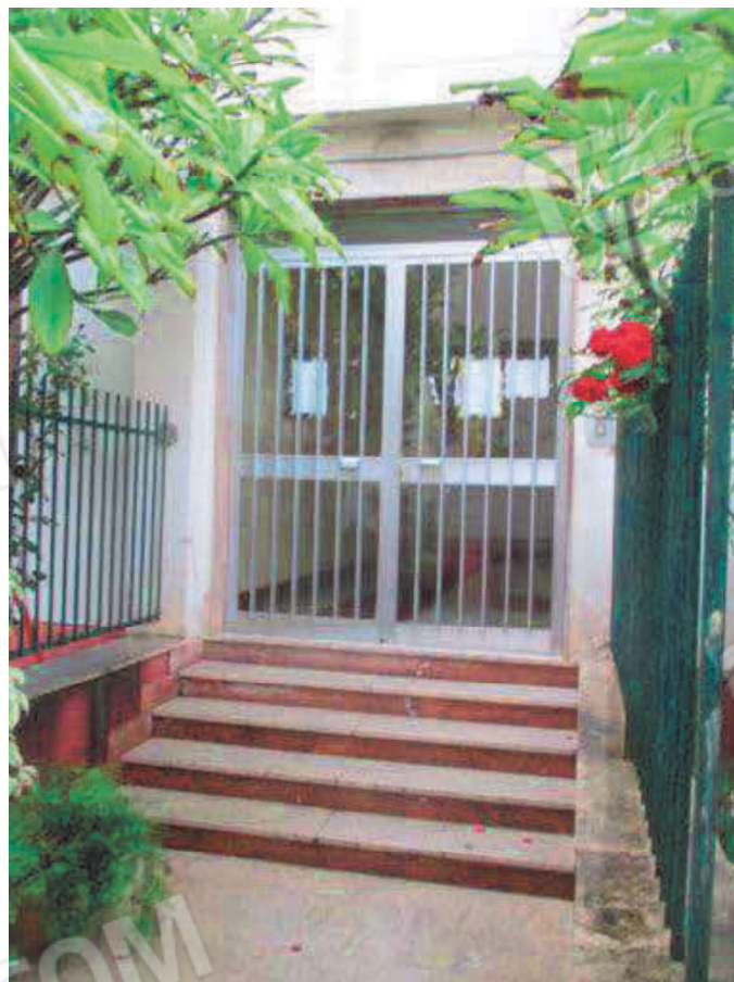
Foto 4 -vista del portone di 'ingresso alla palazzina
