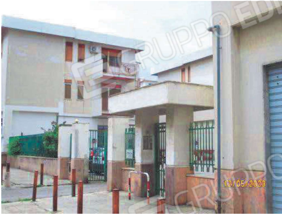
Foto 1 -vista dell'ingresso al complesso sito in Palermo corso dei Mille 1345
