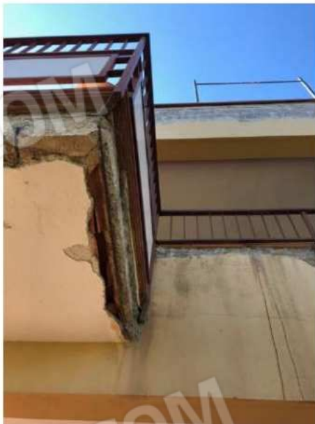
ammaloramenti sotto balconi, pilastri e
