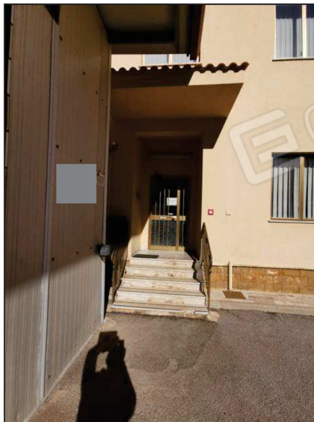
Porta di ingresso alla palazzina uffici (sub. 2)
