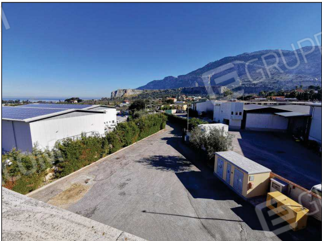
Corte scoperta di accesso agli immobili (sub. 4 - B.C.N.C.)
