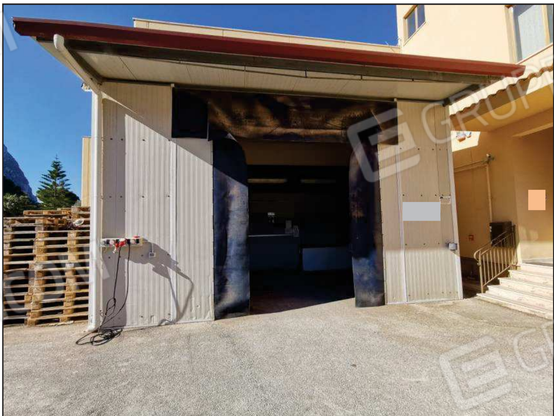
Tettoia di accesso alla cella frigorifera di piano terra (sub. 2)
