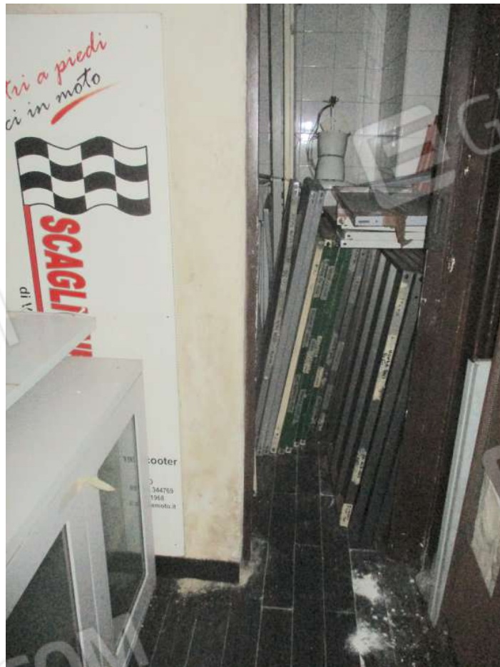
Foto 14: vista del WC del locale
