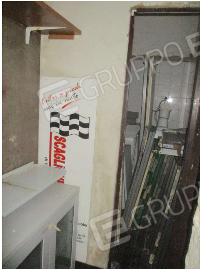
Foto 5: vista del servizio igienico
