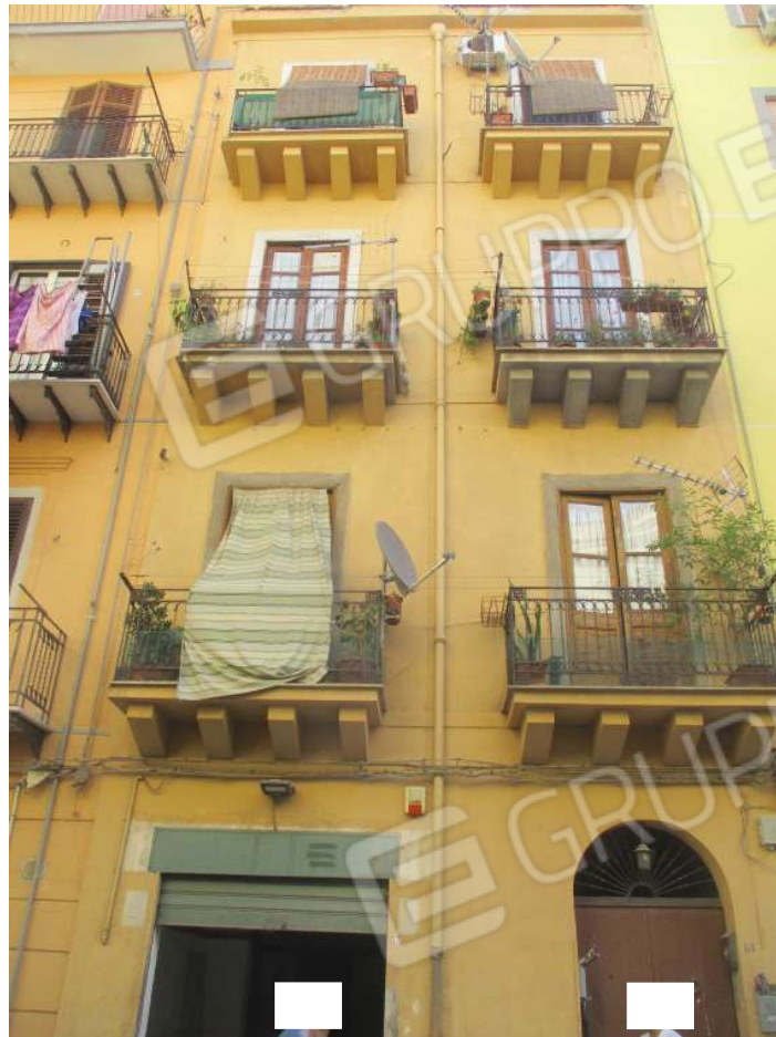
Foto 1: vista dell'edificio sito in Palermo via R.Riolo 61,63
