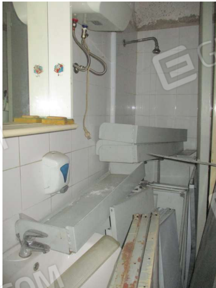
Foto 12: vista del WC del locale
