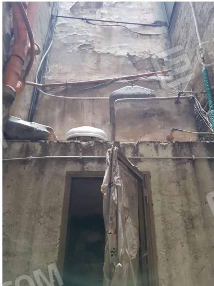
Foto 18: altra vista del piccolo ripostiglio sito nel pozzo luce
