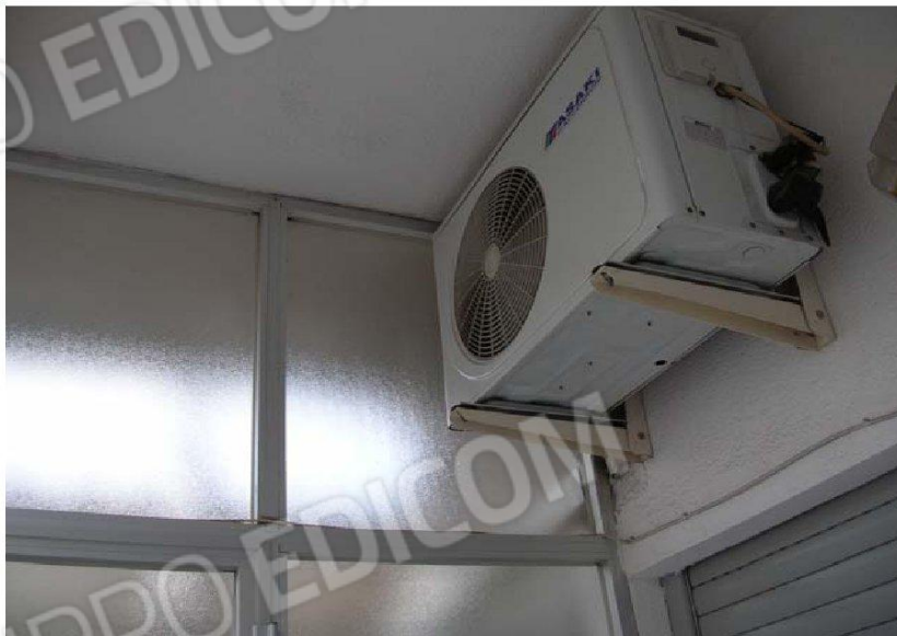
Vista veranda su retrospetto
