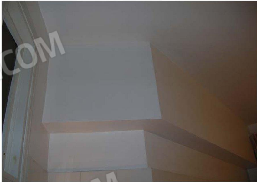
Vista w.c. (particolare finestra su soggiorno)
