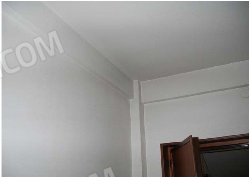
Vista porta ingresso
