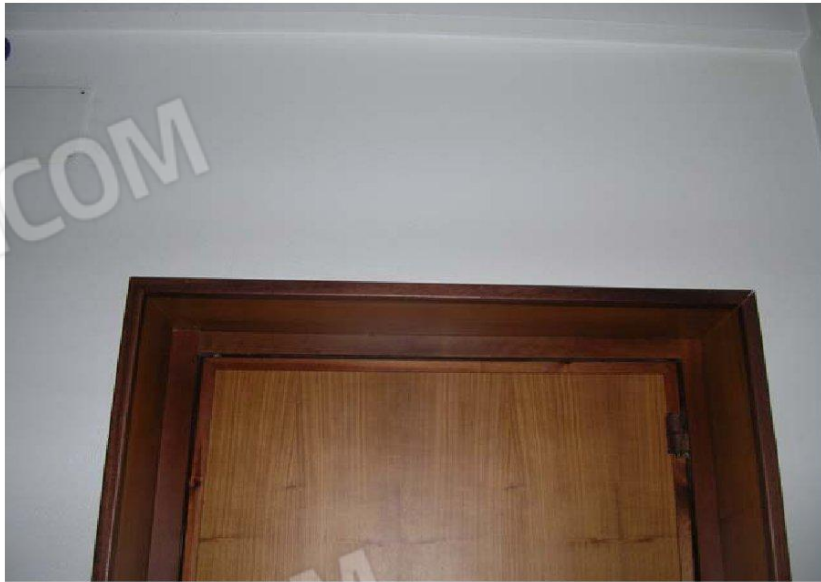
Vista porta ingresso
