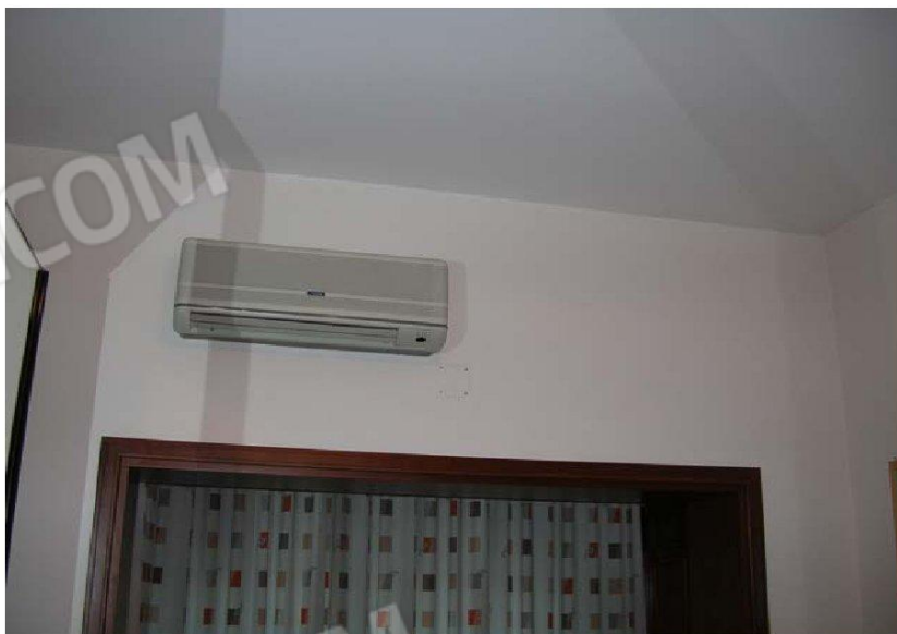
vista camera su cortile interno (particolare vano infisso da ripristinare)
