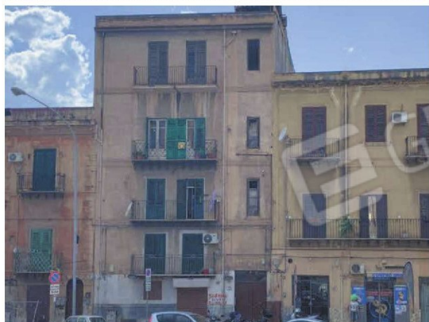
Edificio in oggetto
