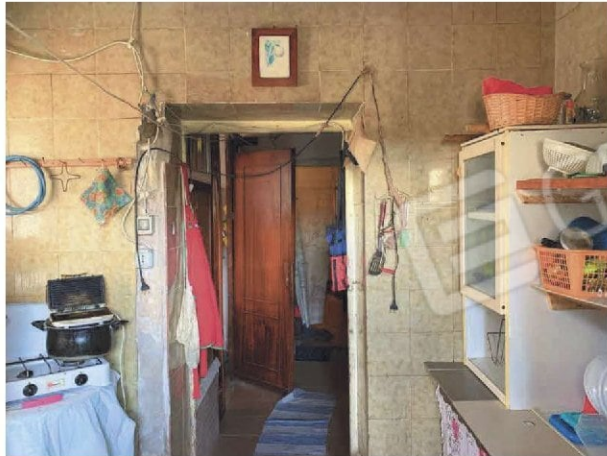
Interni porzione 1: cucina
