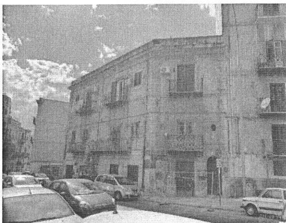
Edificio in oggetto in via Colonna Rotta
