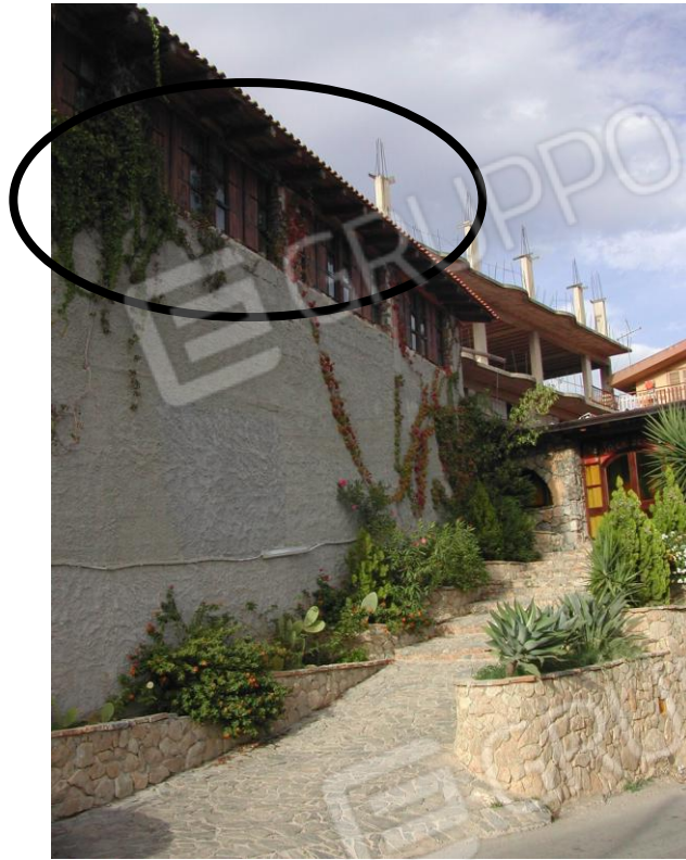
Foto 7 – Prospetto sulla Strada Provinciale
