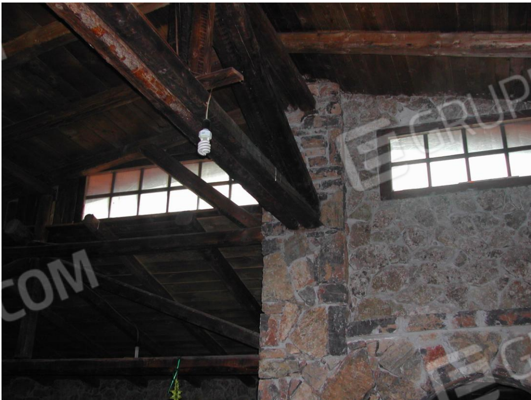
Foto 12 – Copertura con capriate in legno
