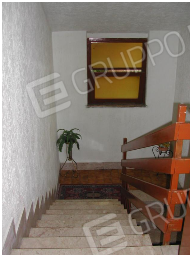
Foto 21 – Scala di accesso al piano 2
