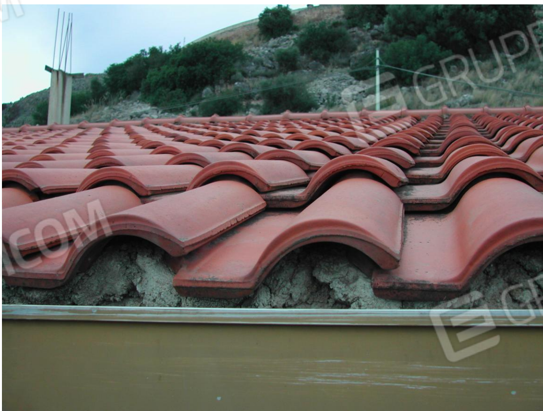
Foto 32 – Copertura con coppi dell'edificio
