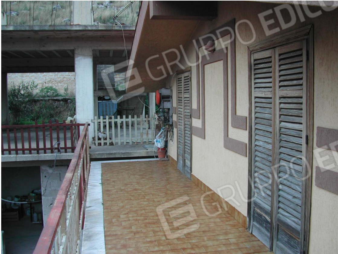
Foto 33 – Balcone sul prospetto laterale al piano 2
