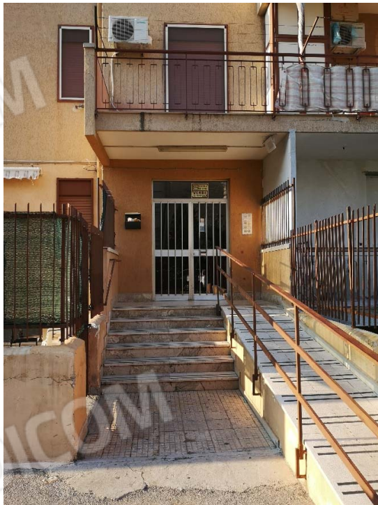
Foto 22 – ingresso allo stabile
