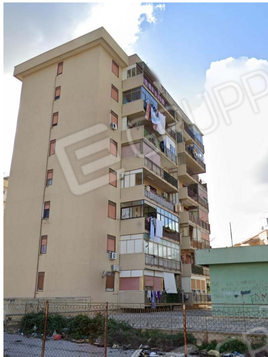
Foto 19 – prospetto su via Bartolomeo Sirillo
