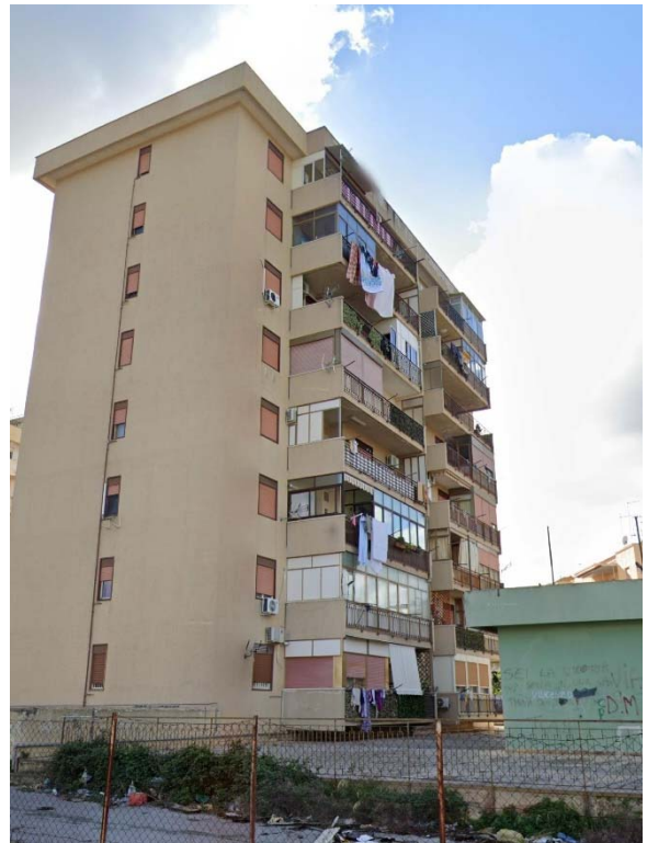
Foto 19 – prospetto su via Bartolomeo Sirillo
