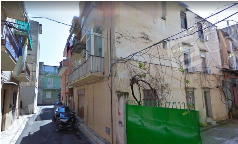
Foto 2 – Prospetto laterale da cortile privato
