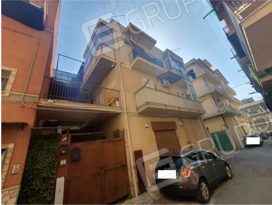
Foto 1 – Prospetto principale da via Gen. A. Di Giorgio n.2
