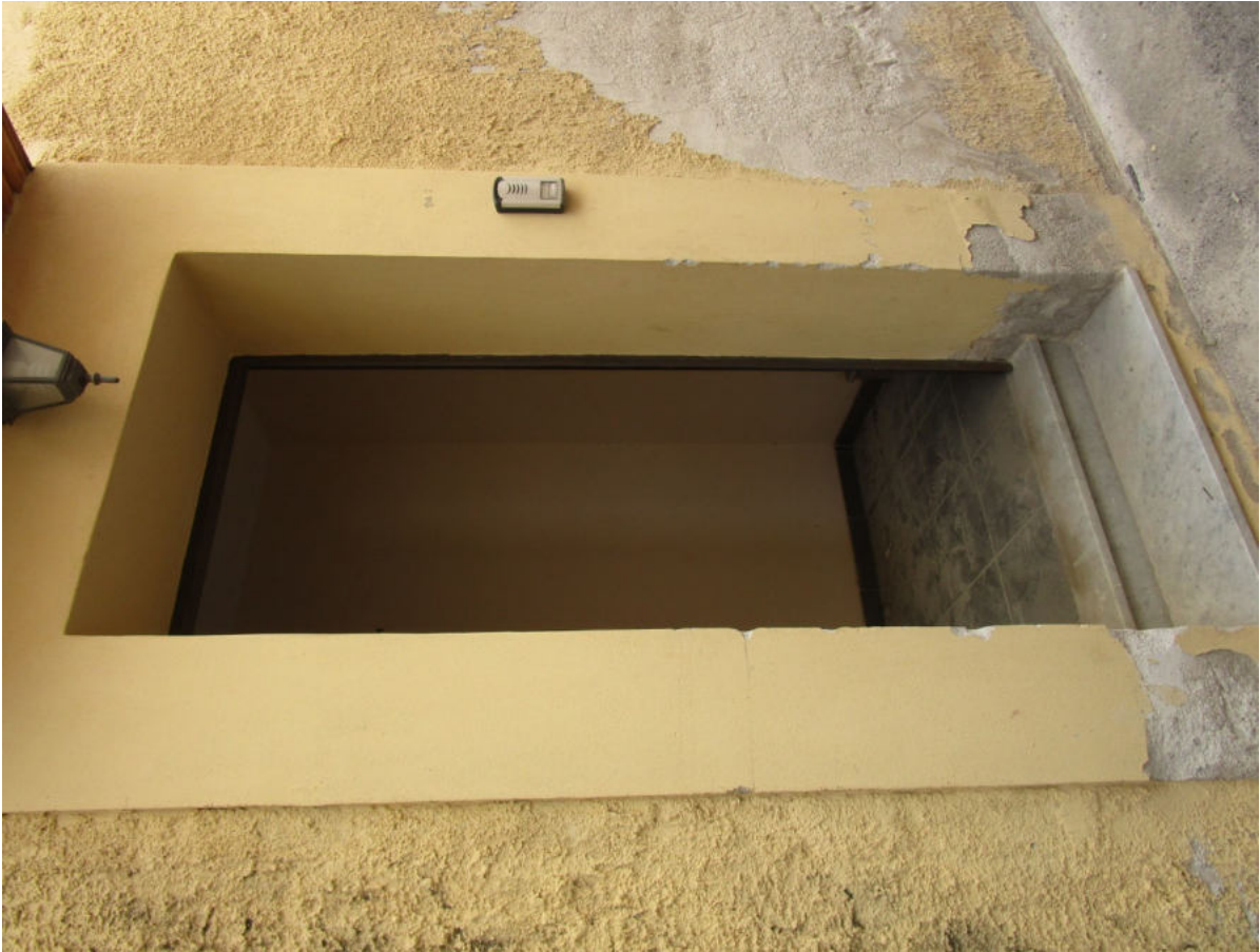
Foto 9 – Il nuovo accesso realizzato su Cortile Giacalone
