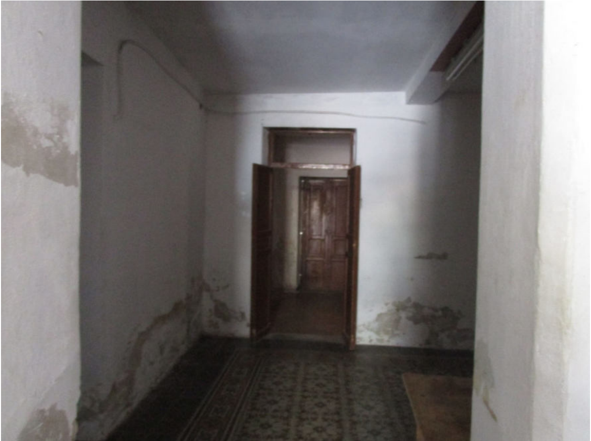
Foto 5 – Interni piano terra
