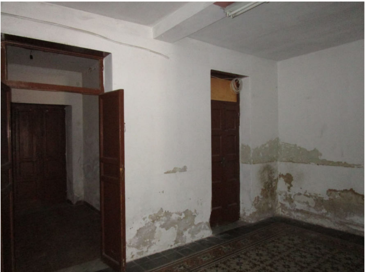
Foto 6 – Interni piano terra
