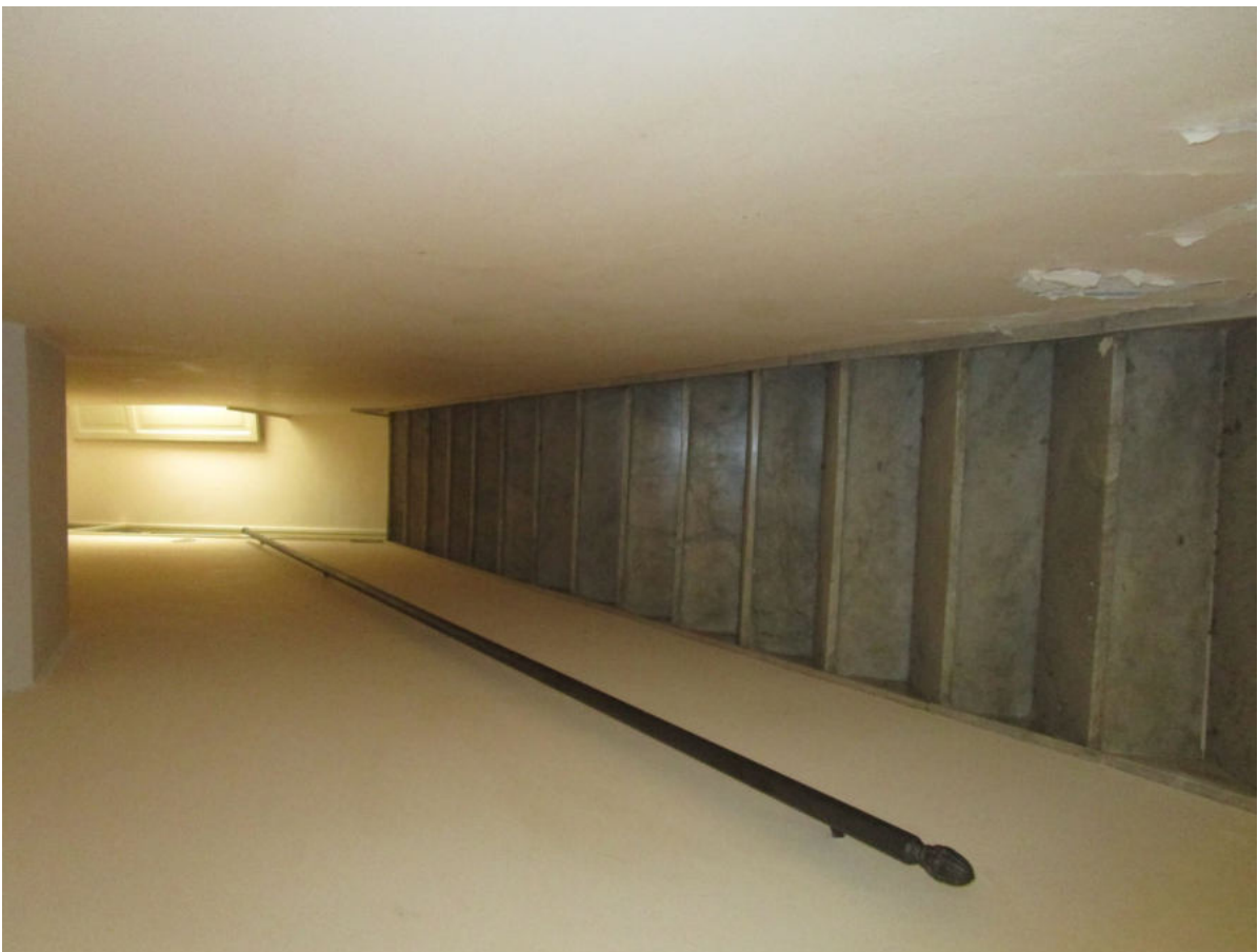
Foto 10 – La scala di accesso al piano 1°
