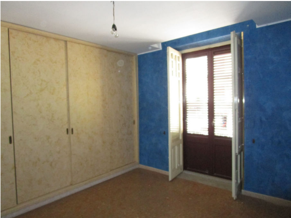
Foto 11 – Interni piano primo
