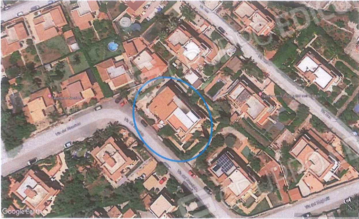
Ripresa aerea del fabbricato oggetto di valutazione
