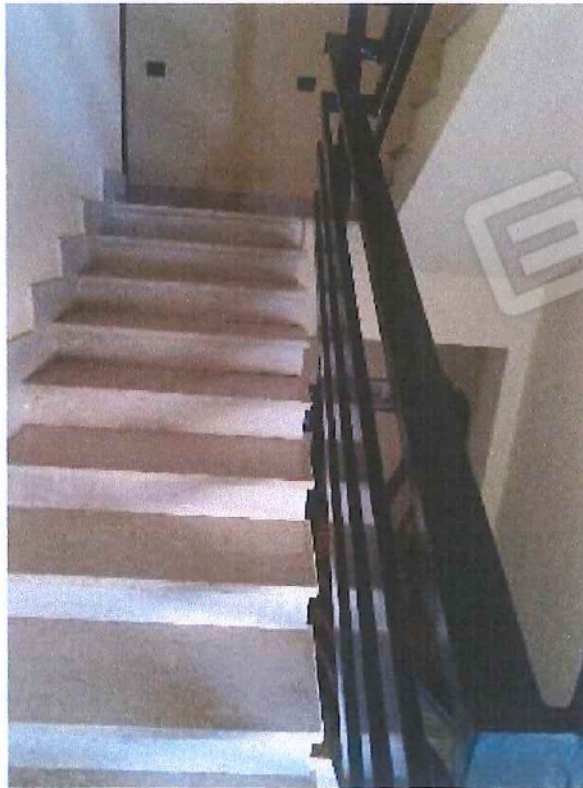
FOTO 6 – Rampa di scale con ringhiera in ferro
