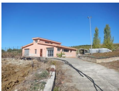
Foto 3 (corpo C - mattatoio)
