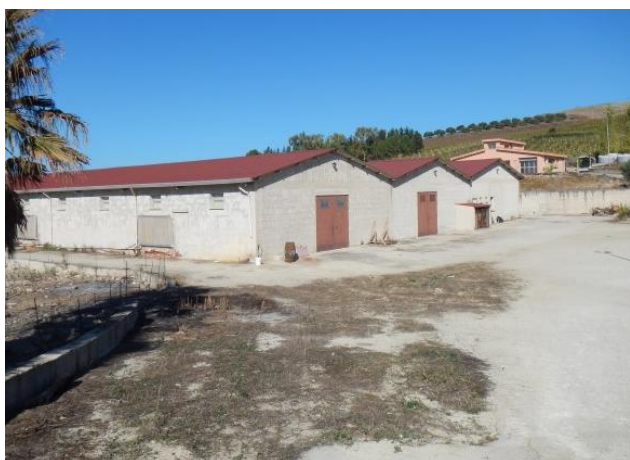
Foto 1 (corpo B - capannone industriale/opificio)
