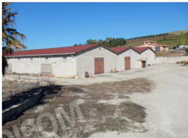
Foto 1 (corpo B - capannone industriale/opificio)
