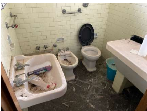
Foto n. 7 – w.c. principale P.T.
