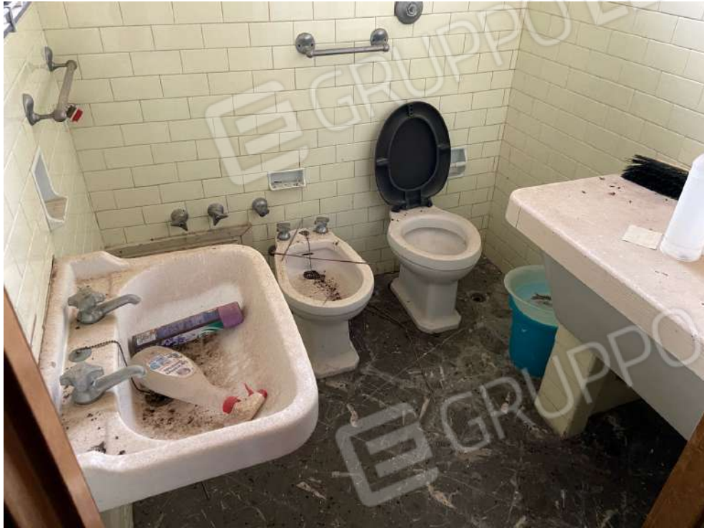
Foto n. 7 – w.c. principale P.T.
