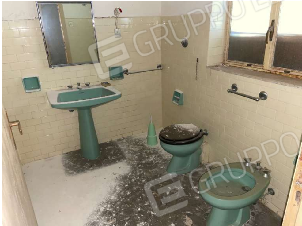
Foto n. 17 – w.c. principale P.1
