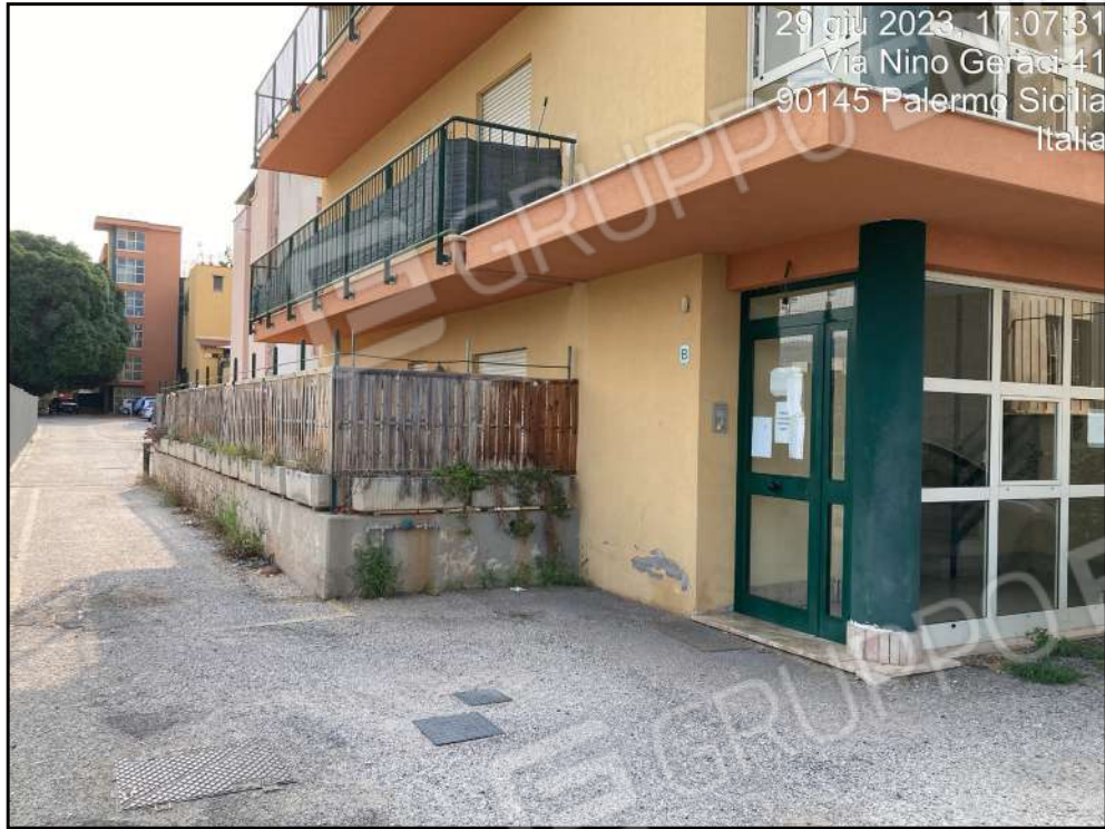
Foto n. 9 - Vista esterna Edificio Scala B
