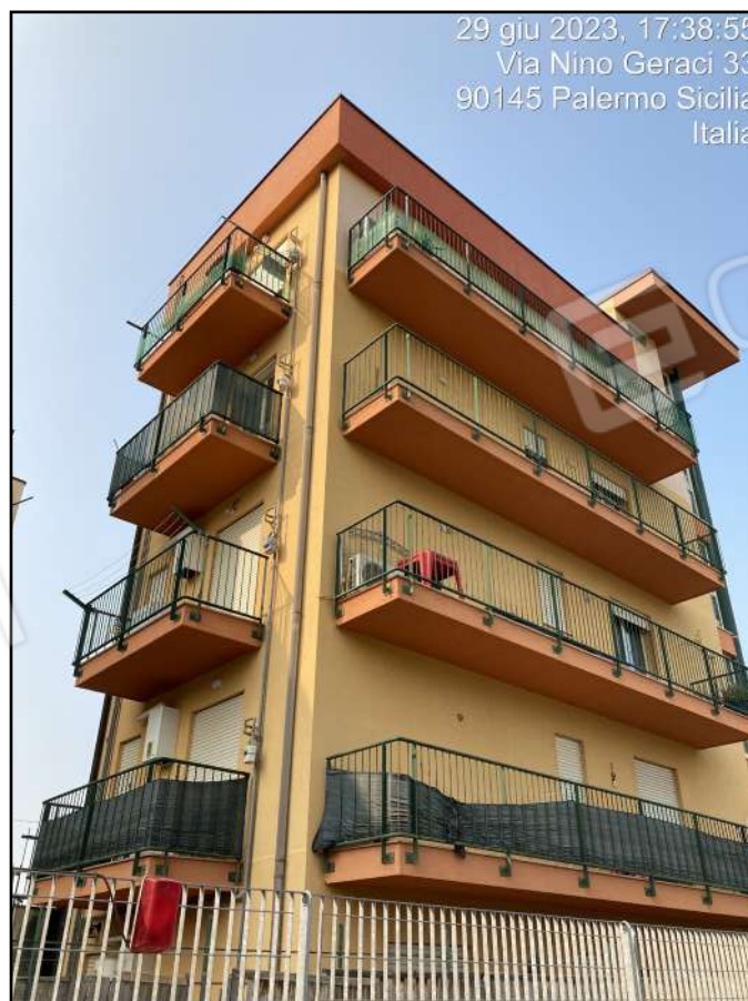
Foto n. 8 - Vista esterna Edificio Scala B
