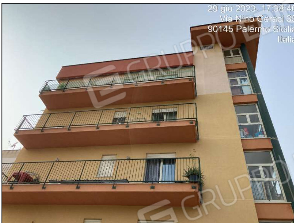
Foto n. 7 - Vista esterna Edificio Scala B
