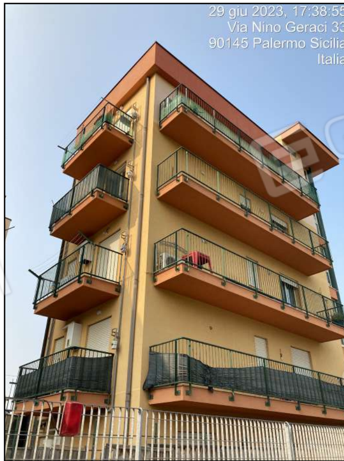
Foto n. 8 - Vista esterna Edificio Scala B
