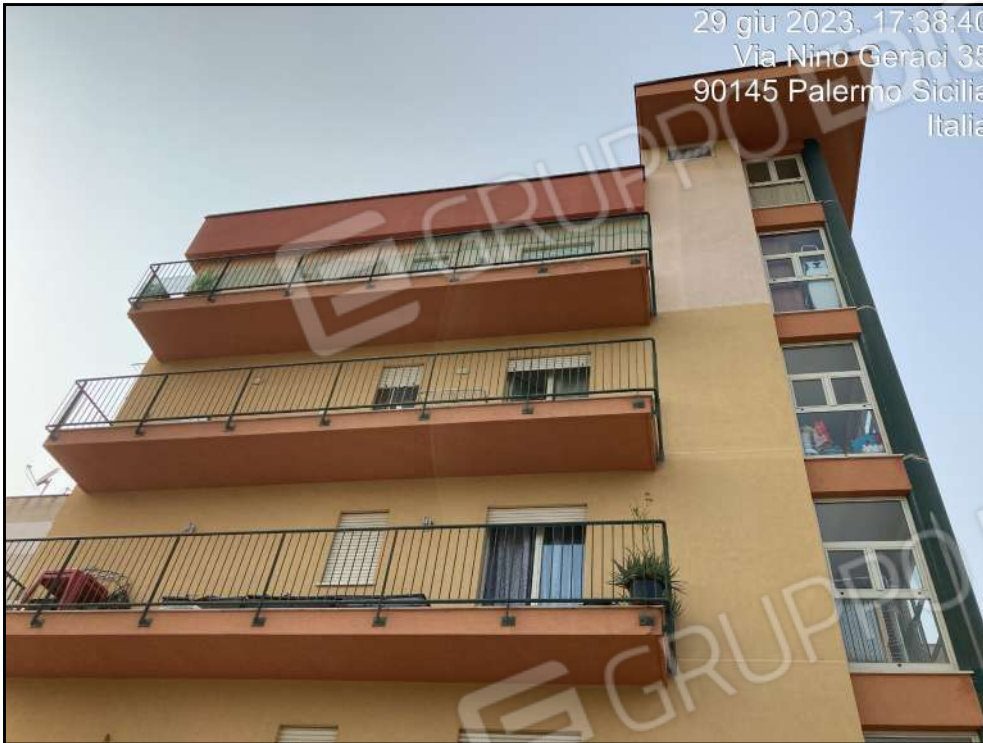
Foto n. 7 - Vista esterna Edificio Scala B
